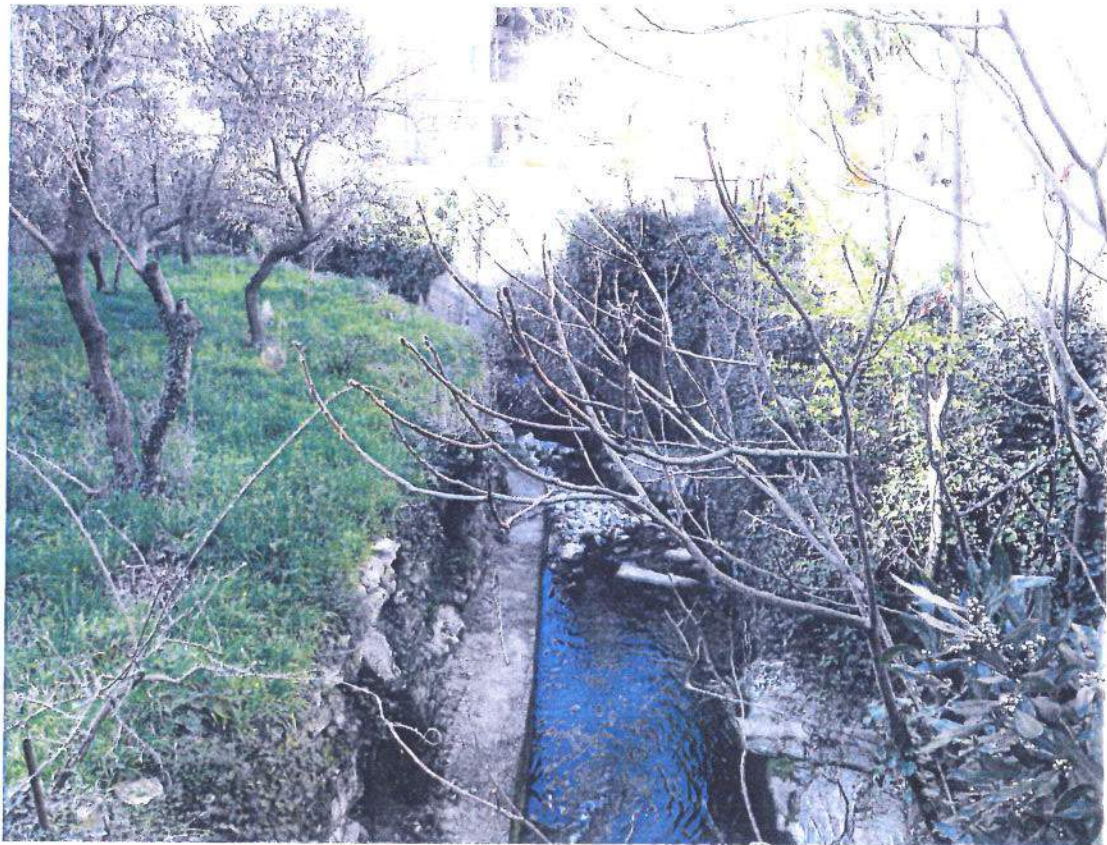
Foto 2: tratto da sez. 17 a sez. 15 – vista da monte
