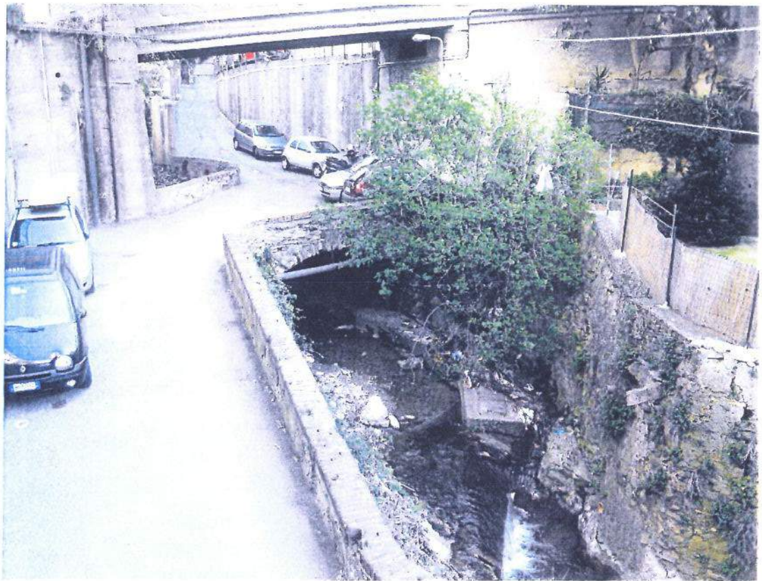
Foto 7: Tratto tra sez. 3 e sez. 1 - Vista da valle
