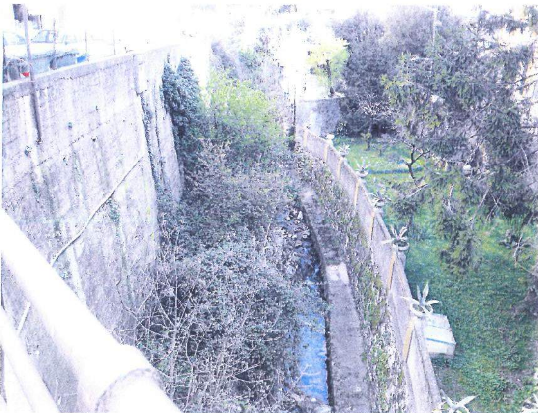
Foto 6: Tratto tra sez. 10.21 a sez. 3 - Vista da valle
