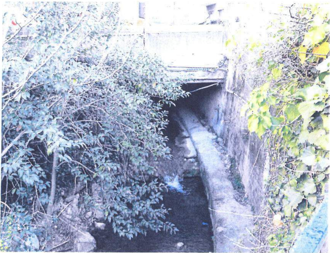
Foto 1: sezione di sbocco tombinatura di monte (da sez. 19.1 a 17.21) – vista da valle
