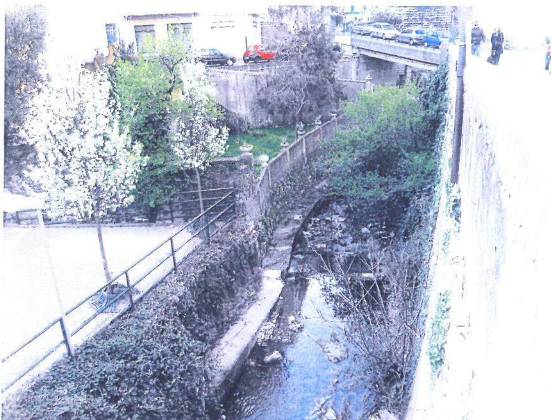
Foto 5: Tratto tra sez. 10.21 a sez. 3 - Vista da monte
