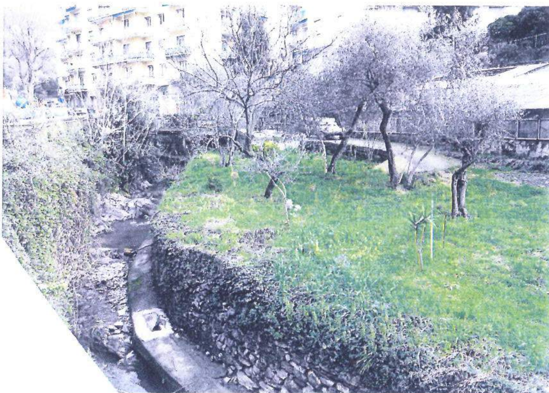
Foto 3: Tratto tra sez. 15 e sez. 13 - Vista da valle
